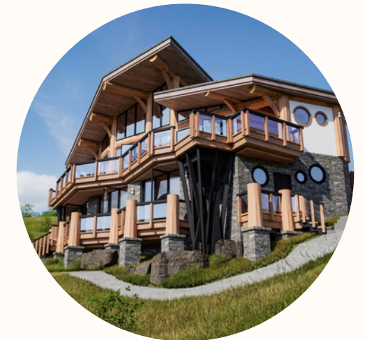
База отдыха для глэмпинга в стиле «Post And Beam»
